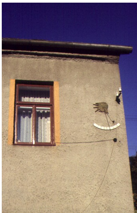
Obr. 8 — Sluneční hodiny v Chocni, Na bílé č. p. 179.
