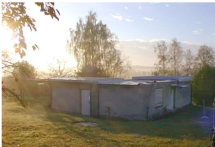
Obr. 5 — Observační pavilon HPHK, ve kterém je umístěn dalekohled Jana Šindela.
