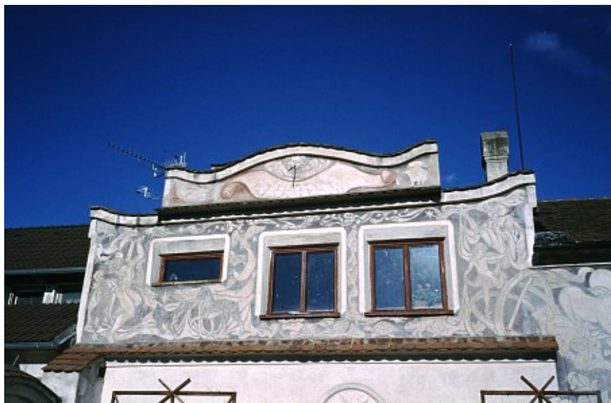
Obr. 7 — Ostřešany . Sluneční hodiny na domě č. p. 11 v Ostřešanech jsou komponovány do sgrafit, která zdobí většinu zdi. Jejich autorkou je paní Eva Filemonová. Nalevo pod hodinami je postava Oriona společně se třemi psy. Napravo jsou symboly znázorňující plynutí času. Hodiny jsou zajímavé především tím, že obsahují pouze jednu datovou úsečku, vyznačující rovnodennost. Pan Emanuel Kuksa, konstruktér hodin, ji využil při sestrojení číselníku po změření příslušného úhlu u paty stěny. Dům je kulturní památkou. Foto Miroslav Brož (2002).
