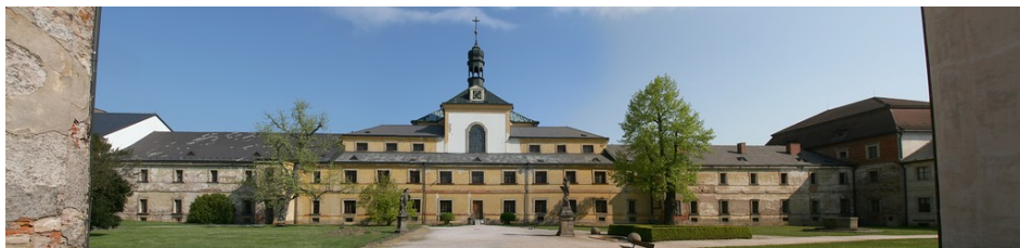
Obr. 14 — Panorama Kuksu se slunečními hodinami nad vchodem.
