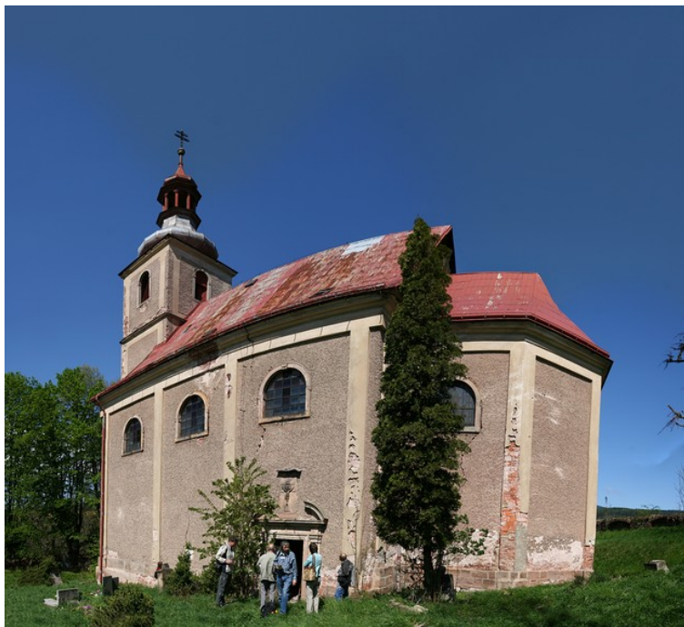
Obr. 16 — Kostel v Javorníku s hodinami nad vchodem.
