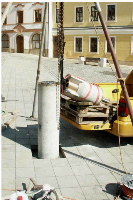
Obr. 18 — (a) Montáž slunečních hodin v prostoru náměstí. Foto Jan Pospíšil. (b) — Nastavování slunečních hodin do správné polohy, aby stín ukazatele mířil svisle dolů. Foto Martin Samohrd.
