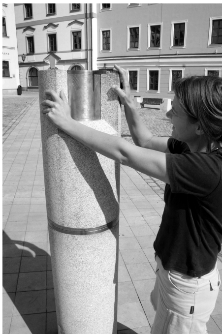
Obr. 18 — (a) Montáž slunečních hodin v prostoru náměstí. Foto Jan Pospíšil. (b) — Nastavování slunečních hodin do správné polohy, aby stín ukazatele mířil svisle dolů. Foto Martin Samohrd.
