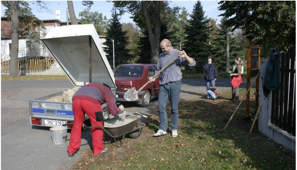
Obr. 16 — Betonování sloupků Galaktické stezky 7. 10. 2007.
