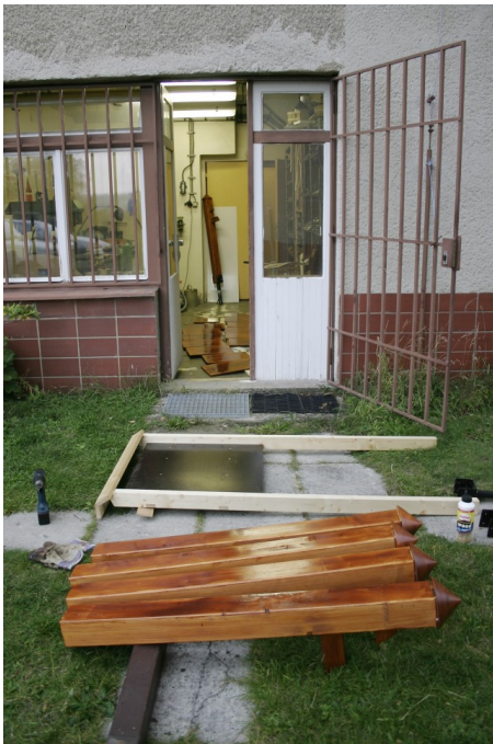
Obr. 17 — Přípravné práce v dílně hvězdárny.
