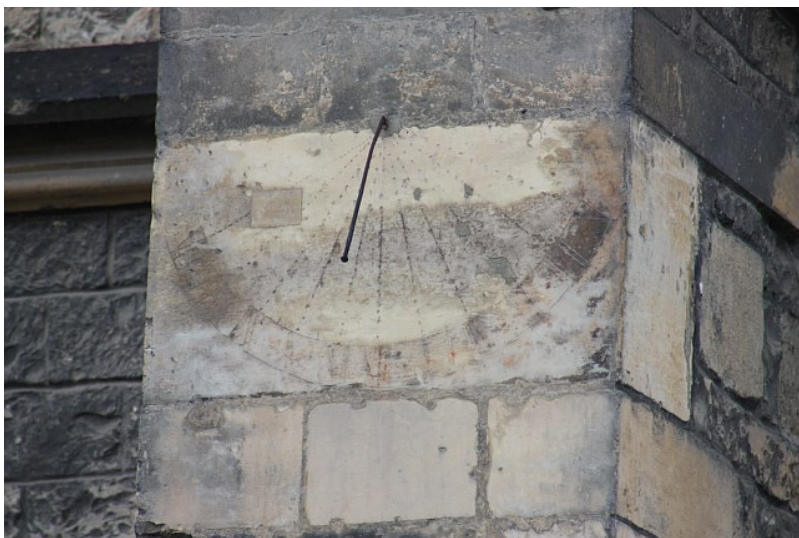
Obr. 1 — Sluneční hodiny na kostele Sv. Mikuláše v Lounech (ev. č. LN 8). Foto Pavel Uhrin.
