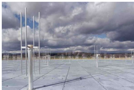
Obr. 11 — Radar GRAVES, přijímací část — soustava antén vzdálených 400 km od vysílače.
