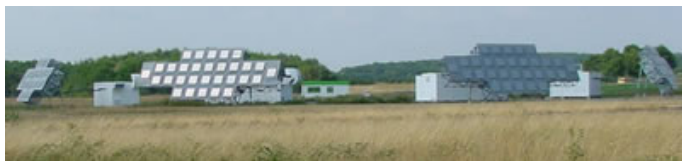
Obr. 10 — Radar GRAVES, vysílací část 4 separátní fázované anténní soustavy. Každá anténní soustava pokrývá 45 stupňů v azimutu.
