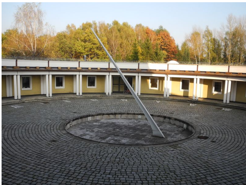
Obr. 24 — Chorzów, hvězdárna a planetárium; vodorovné sluneční hodiny.
