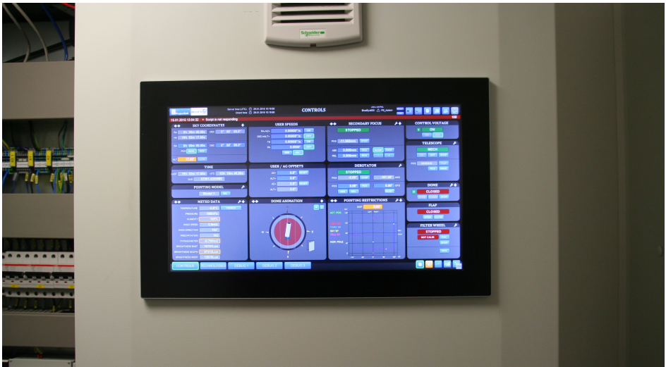
Obr. 15 — Manuální ovládání observatoře je možné pomocí vizualizace (SCADA) Tompack. V tomto případě je spuštěna na dotykovém monitoru, umístěném přímo na rozvaděči, a lze ji tak využít při servisních zásazích.
