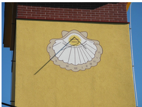
Obr. 25 — Svislé sluneční hodiny ve Sviadnově.
