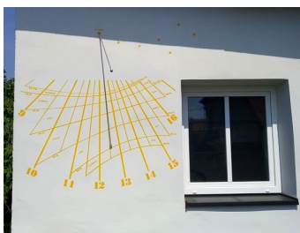
Obr. 13 — Martinice 38, okr. Kroměříž, ev. č. KM 36.
